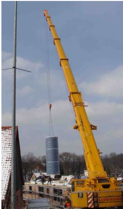
Mit einem riesigen Autokran wurde der 30 000-Liter-Tank im Fundament versenkt.
